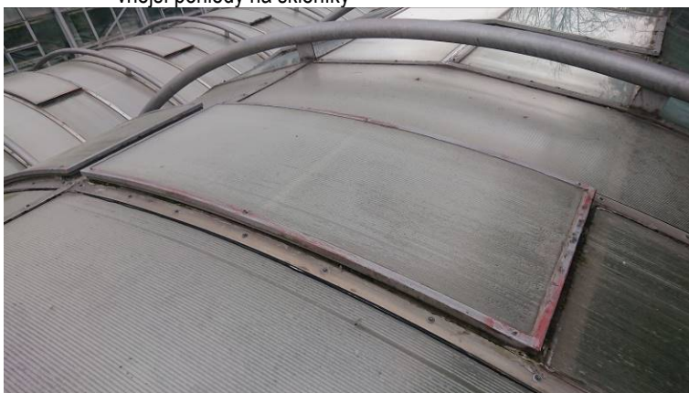
- zasklení polykarbonátem (větrací prvky)
